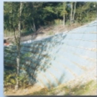
Bewehrung von Böschungen, hier Gänsbergspange Idstein
