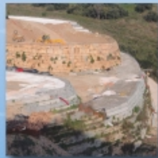
Bewehrung von Stützkonstruktionen, hier Marbella/Spanien
