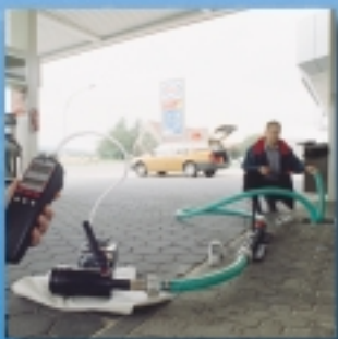
Überwachung von Tankstellendichtungen, hier Tankstelle Schmale in Lübbecke-Blasheim
