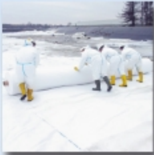
Überbauung von Schlammteichen, hier Schlammteich Erlte
