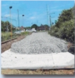
Bewehrung mineralischer Schichten, hier Gleiserneuerung Grombach
