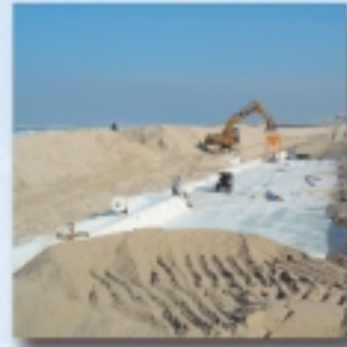
Küstenschutz mit Geotextilien, hier Figuera da Foz, Portugal
